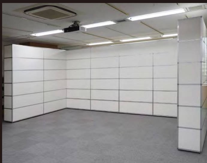
メディアシートを貼る前
